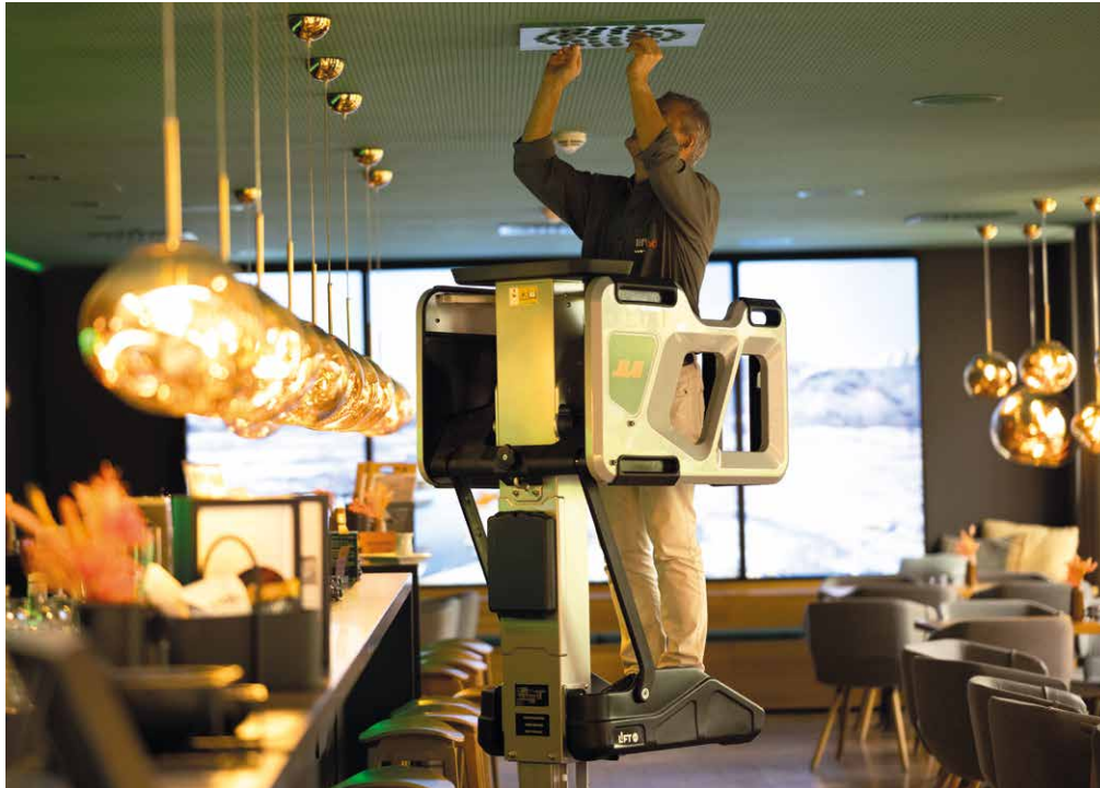
Liftpod im Einsatz
